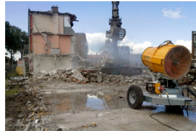
Achter de Poort, Culemburg: ontmanteling per fase tegelijk aanbesteed met nieuwbouw versimpelt uitwisseling materialen.
